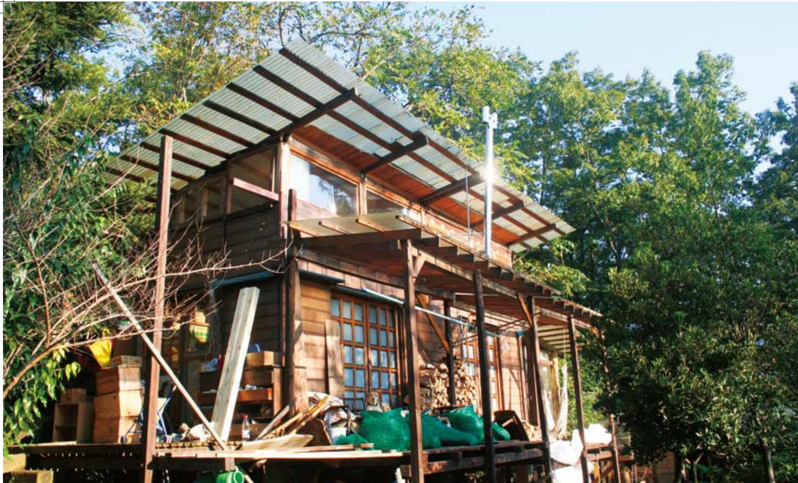
誰かに教えてもらったわけではなく、経験を重ねてたどり着いた名付けて「大吾工法」で、集まったみんなの力を借りて建てられた加藤さんの自宅。
